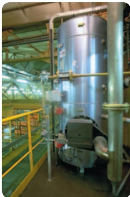
Les gaz de combustion poussés par le ventilateur du brûleur, sont conduits à travers un échangeur fumées liquide réalisé en acier inoxydable, immergé dans l'eau du réservoir. Ils communiquent à l'eau, tout au long de leur parcours, la chaleur issue de la combustion.
