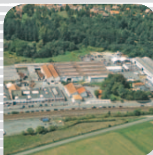
Site de fabrication - Pons
