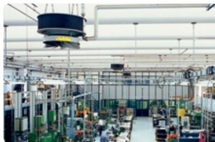
Un des avantages importants des aérothermes Comfort Sabiana est de pouvoir choisir parmi 4 types de diffuseurs celui qui sera le plus adapté aux exigences thermiques pour chauffer un vaste volume avec un nombre d'appareils et un coût d'installation optimaux.
