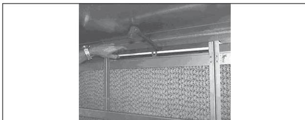
Raccorder la rampe au réseau d'alimentation d'eau de ville pour rincer. Si nécessaire, nettoyer les orifices avec un outil pointu puis rincer à nouveau. Nettoyer le bac après l'avoir vidé. Remplir le bac et contrôler le niveau d'eau.
