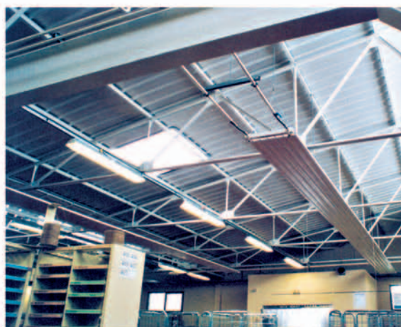
La Poste - Centre de tri d'Annecy (74)
