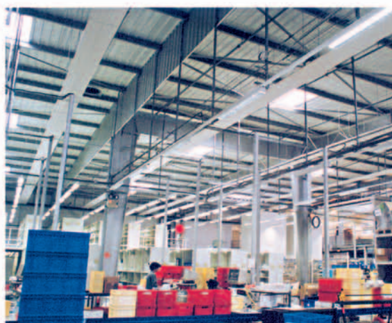
Entrepôts Depuy - Saint Priest (69)
