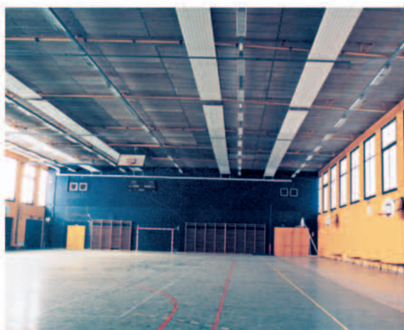
Gymnase de Montrevel en Bresse (01)
