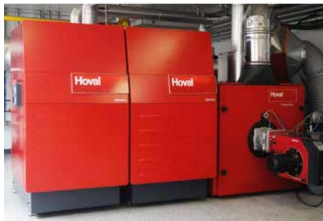
Cascade monovalente de 2 UltraGas® et d'1 CompactGas.
