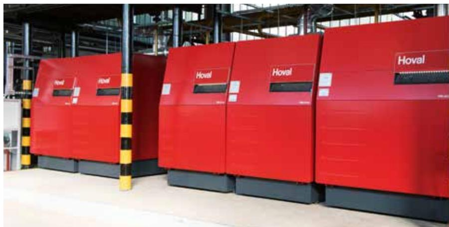
Centrale de chauffage pour un réseau de chauffage urbain : 1 chaudière UltraGas® (1000) et 2 chaudières double UltraGas® (1300D) assurent le chauffage et l'alimentation en eau chaude sanitaire de 1 578 habitations. La répartition de la charge sur 5 chaudières offre une adaptation optimale de la puissance et une efficacité maximale, tout en garantissant la meilleure sécurité opérationnelle.
