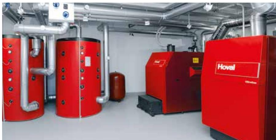
Cascade bivalente dans un bâtiment d'entreprise : chaudière à pellets BioLyt (160) pour les besoins thermiques de base et chaudière gaz à condensation UltraGas® (250) pour couvrir les pics.
