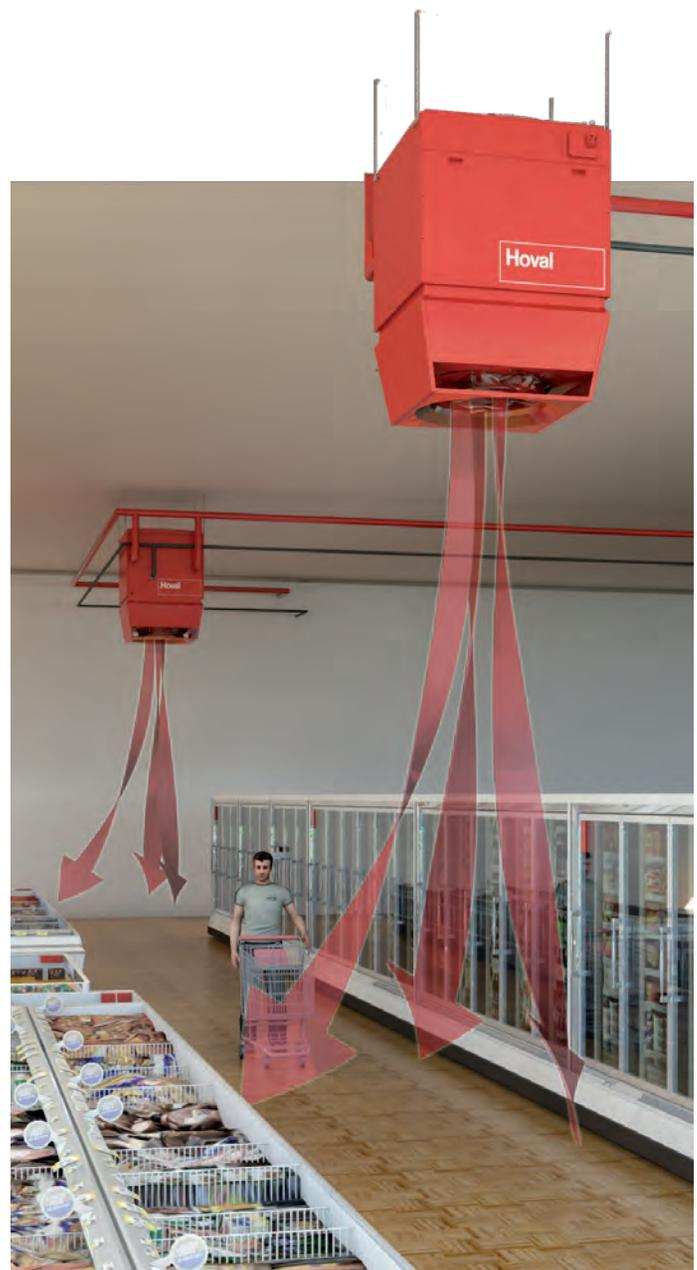
Un élément indispensable du système EcoLine est le diffuseur giratoire breveté Air-Injector.
