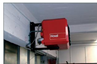
Les TopVent® GV sont destinés à être installés sous la toiture ou sur un mur.
