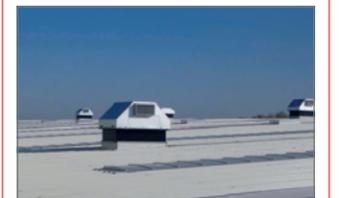
Les appareils TopVent® commercial sont installés directement dans la toiture.
