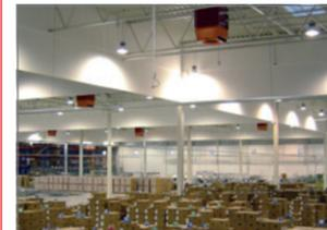
Les appareils TopVent® DKV sont adaptés aussi bien pour le chauffage que pour le refroidissement de halls.
